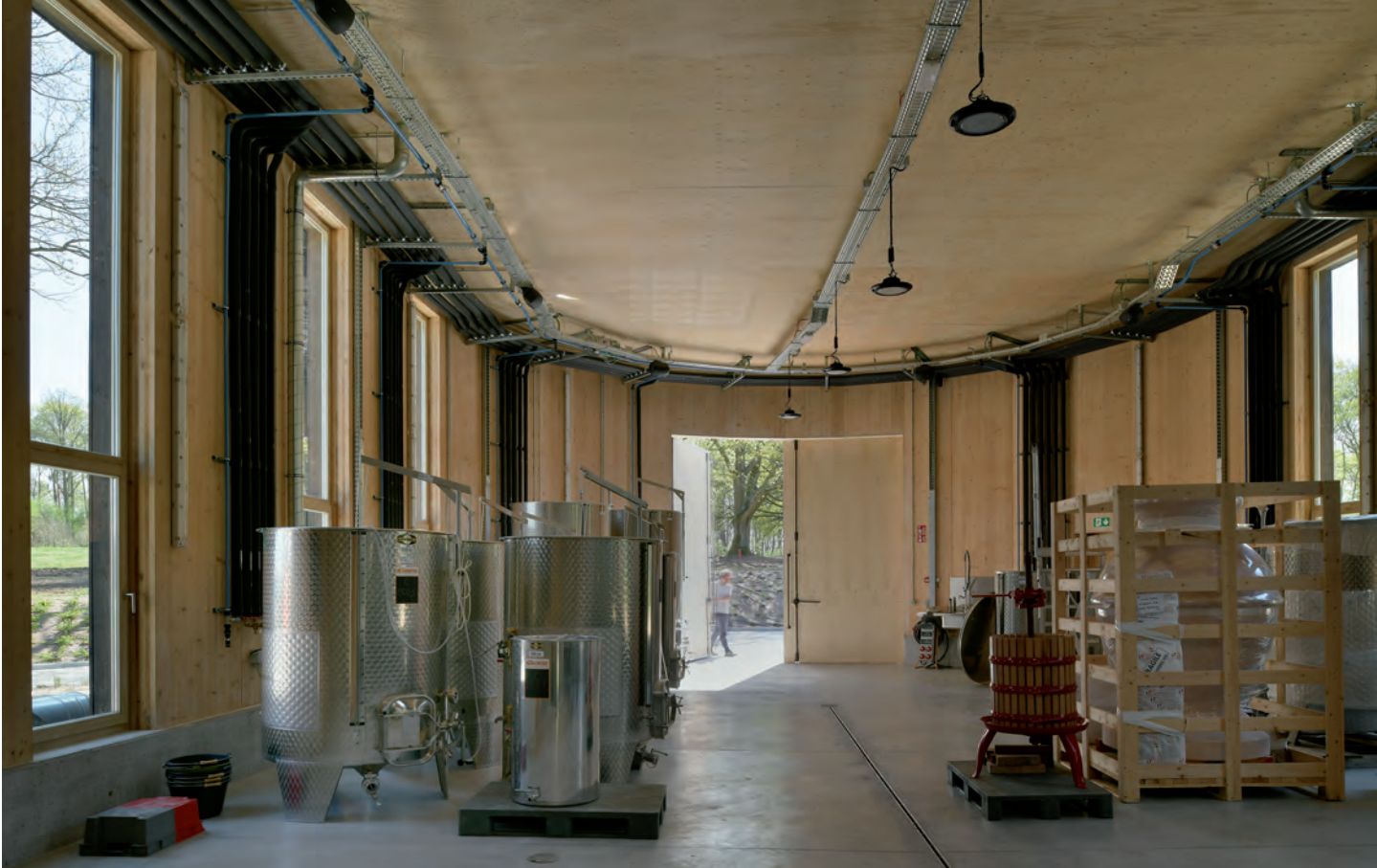
De wanden, plafonds en de machtige deuren aan de hoogste zijde van het gebouw zijn uit LVL gemaakt.
